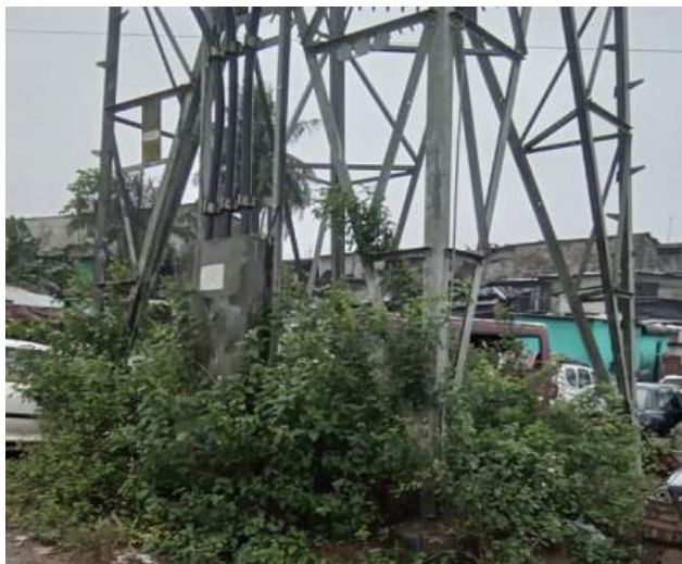
Vue de la Fondation d'un pylône
