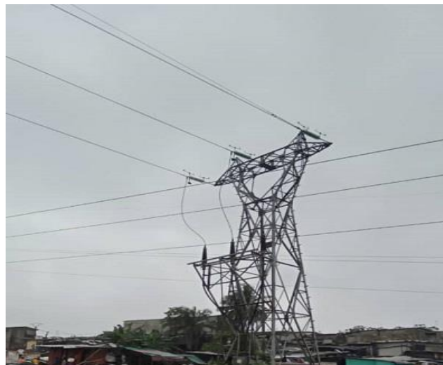
Vue aérienne d'un pylône
