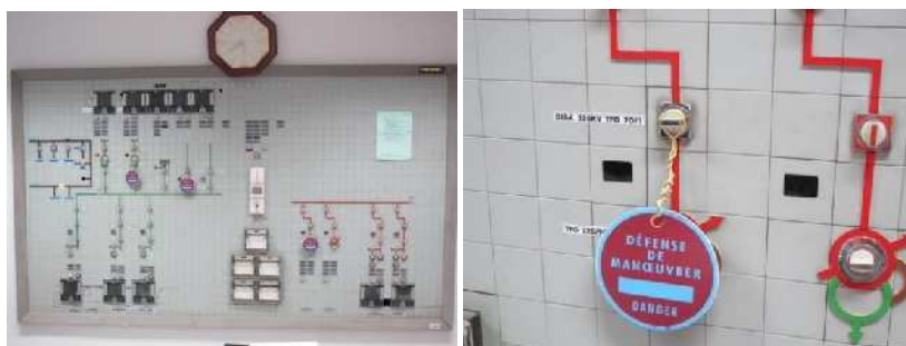
Photo 2: Consignation d'une ligne au poste source, GBEGBO Fulgence, 2017
