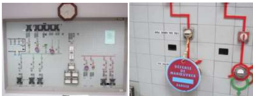
Photo 14: Consignation d'une ligne au poste source, GBEGBO Fulgence, 2017
