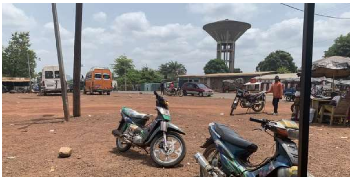
Photo 10: château d'eau de Danané
