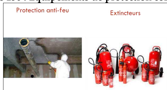
Figure 136 : Equipements de protection collective
