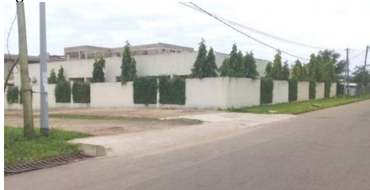
Figure 124: Vue d'un habitat résidentiel à Grand-Lahou
