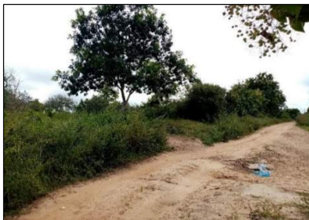
Vue d'un tronçon de la route menant à Cissé Dougou
