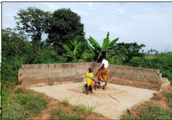
Vue d'une pompe hydraulique villageoise dans le village de Tiekourasso
