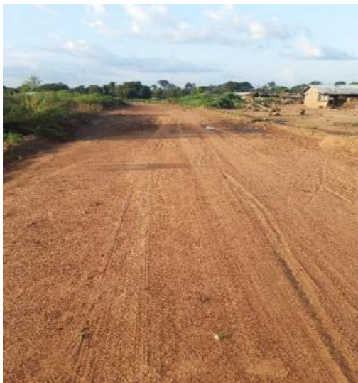
A: vue de la voie menant à Ouattarasso
