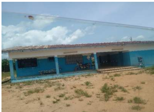
Vue du centre de santé de SANHOUMAN
