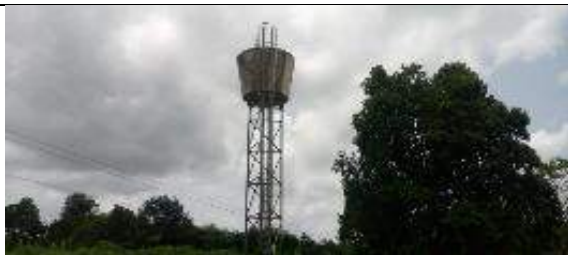
Vue d'un château d'eaux non fonctionnelles à Wogninkro
