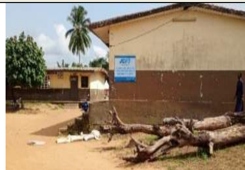
Vue d'une école primaire à MAFERE (Groupe scolaire Aka Aouélé)
