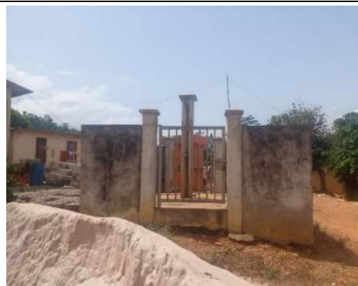
Vue d'une Pompe
