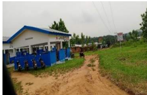
Vue du Centre de Santé de BABADOUGOU
