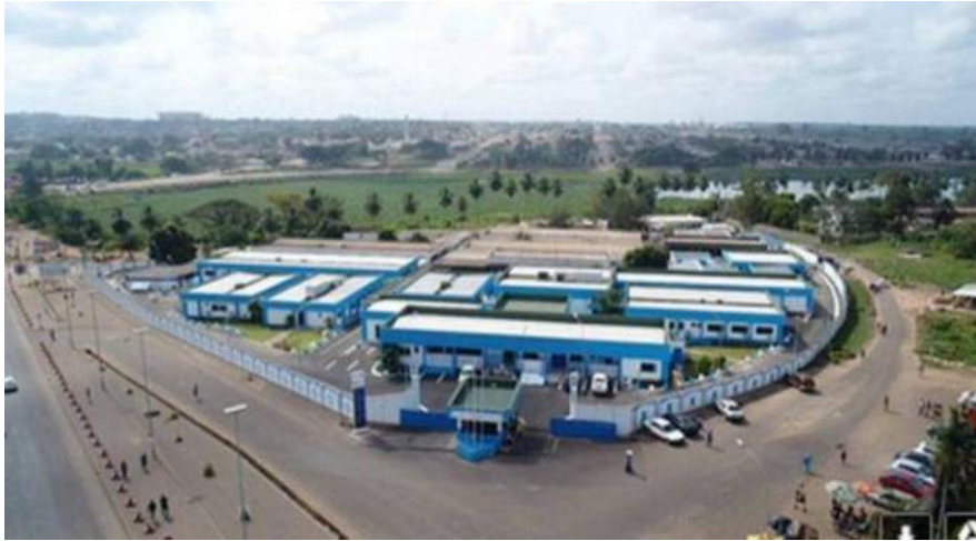
Photo 21 : Vue de l'hôpital Général de la SOTRA
