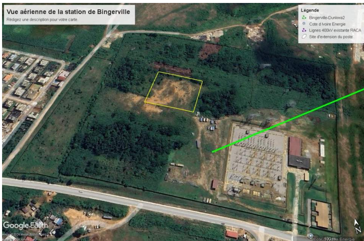
Figure 14: Emplacement des futures installations du poste de Bingerville
