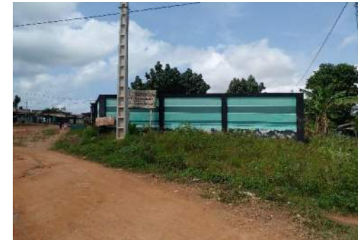
Vue des installations à Akouré
