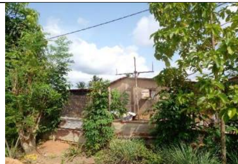
Vue d'un bâti à YAPOKRO
