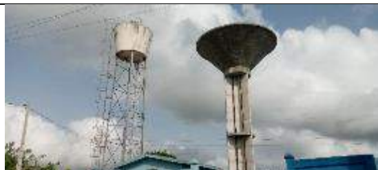
Aperçu d'un château d'eaux à Assé
