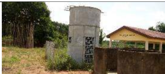
Système hydraulique à Nougoussi
