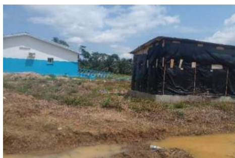
Le centre de santé en construction
