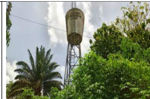
Vue du château d'eau
