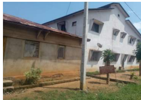
Vue de bâtis à Akouré
