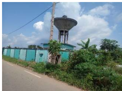
Château d'eau de M'BATTO -BOUAKE
