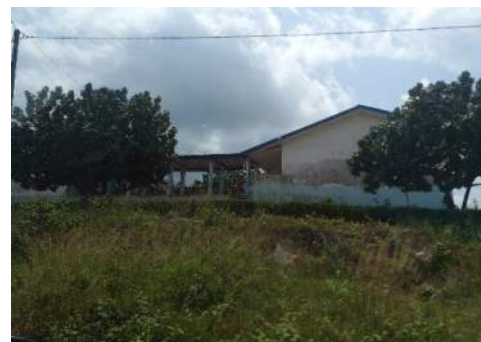
Vue du centre de santé Rural de TOLIESSO
