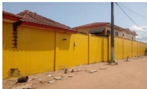
Vue d'un bâti de type moderne à ADAOU
