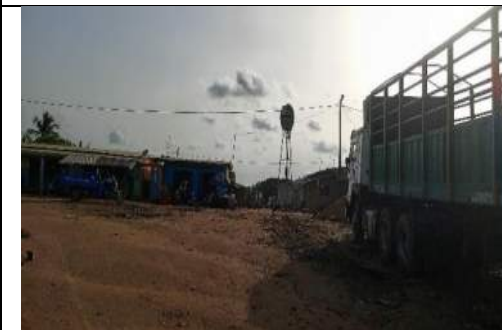
Image présentant une installation Hydraulique Villageoise Améliorée à Ahigbé-Koffikro
