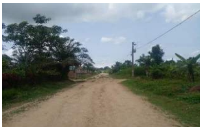
Vue d'une voie du village à N'gokro
