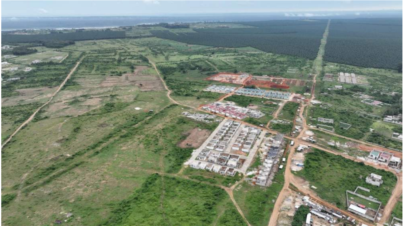
Figure 8 vue de la ligne existante Bingerville-Pretea et de la périphérie de Bingerville autour du côté est de la sous-station.
