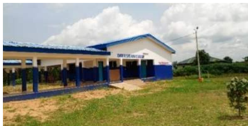
Vue du Centre de Santé de DIATOKRO
