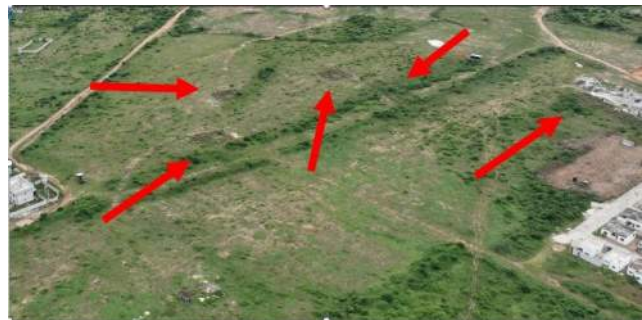
Figure 10: Excavation pour les fondations de nouveaux bâtiments en cours de construction lors de la visite du site
