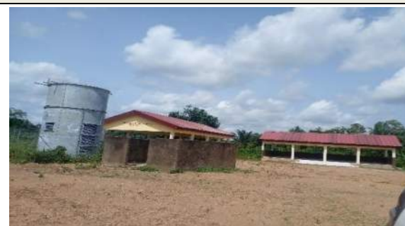
Vue d'une pompe avec Energie solaire et d'un foyer à Nougoussi
