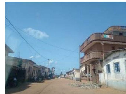
Vue d'une voie et bâtis à ELOKA-TO
