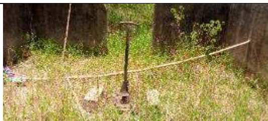
Forage à motricité humaine non fonctionnel à N'djarakro
