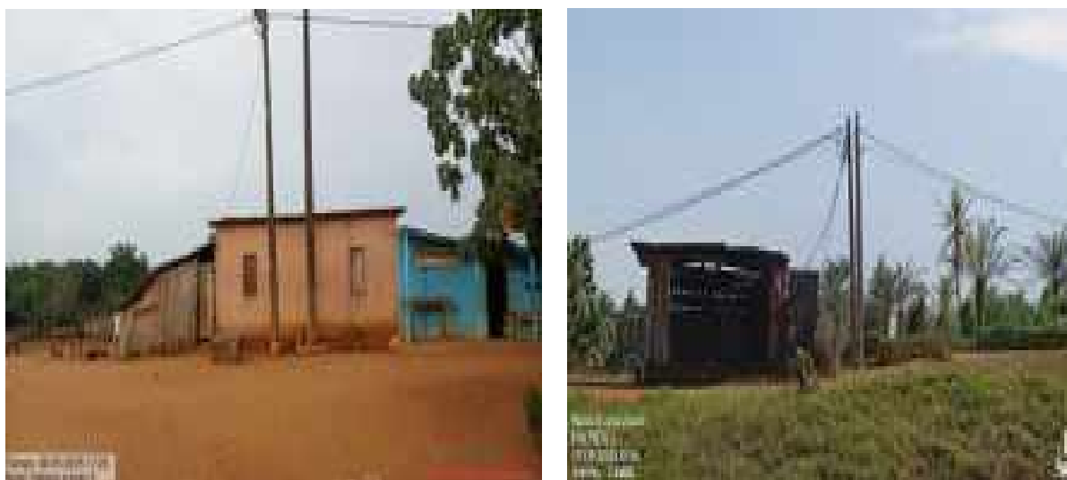
Vue du type d'habitat de Koto 3 (cases en planche, prise de Vue du groupe électrogène de Koto 3 vue 08 mai 2025)
