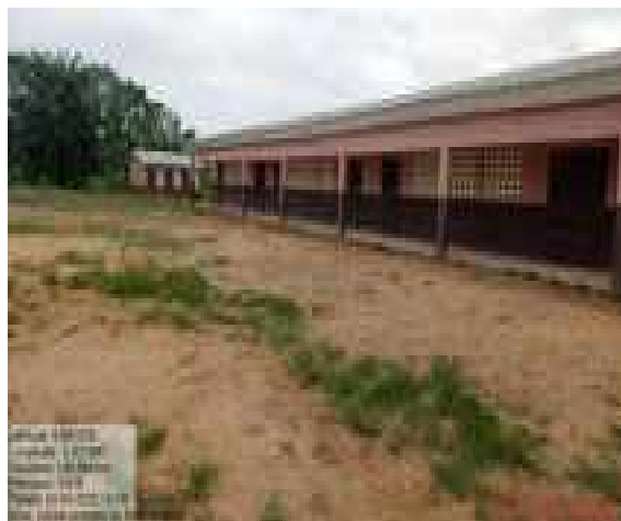
Vue de l'école primaire de Ballodougou (la cour, l'un des bâtiments et les toilettes de l'école, 02 mai 2025)
