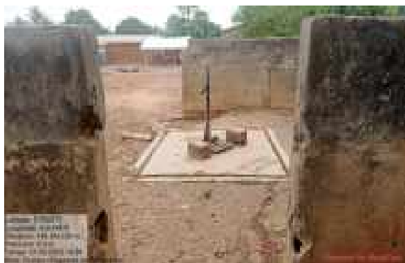
Vue d'une pompe hydraulique, 01 mai 2025
