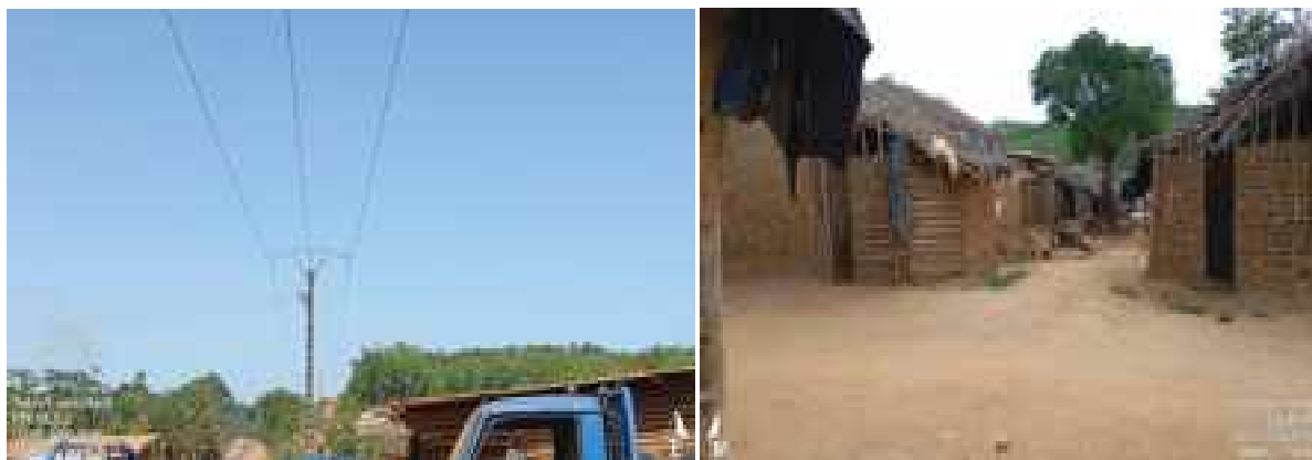
Vue de la ligne électrique MT de Nané 2 (prise de vue 07 mai 2025) Vue de l'habitat traditionnel à Nané 2 (cases en banco, prise de vue 07 mai 2025)
