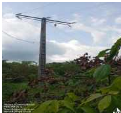
Vue d'un poteau électrique en béton d'une ligne MT à Bertinkro, 28 avril 2025
