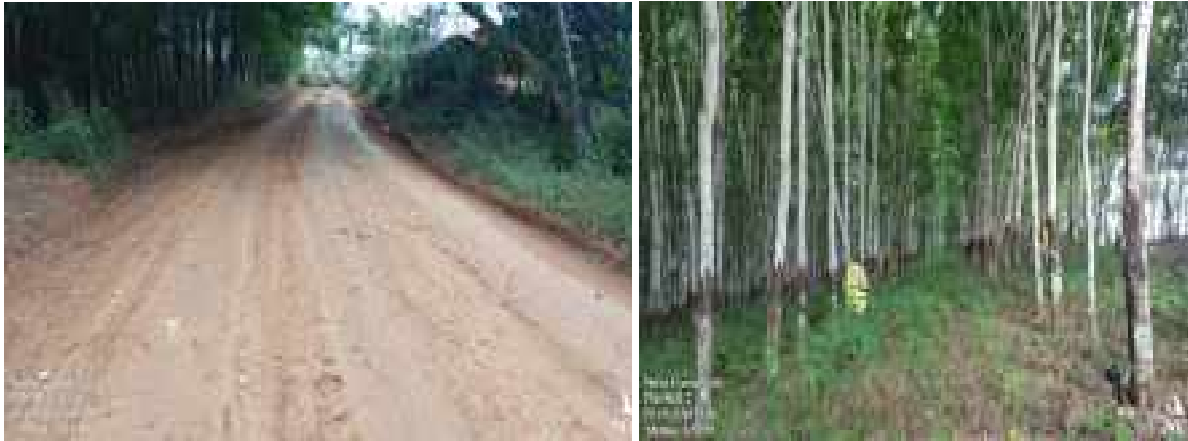
Vue de la voie d'accès à Pahisso, traversant une plantation d'hévéa, prise de vue 07 mai 2025)
