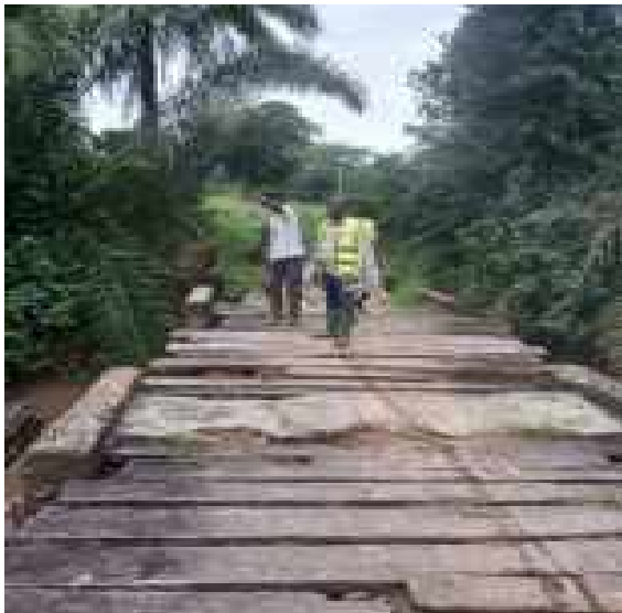
Vue du pont de fortune reliant Opouyo à Kouadio-Bernardkro, 02 mai 2025
