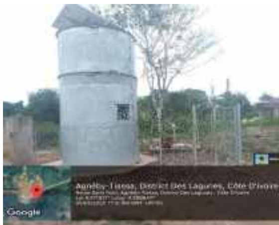
Le forage de Gboaho
