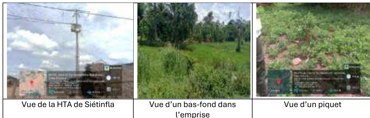
Planche 21 : Vue de l'occupation de l'emprise de la ligne
