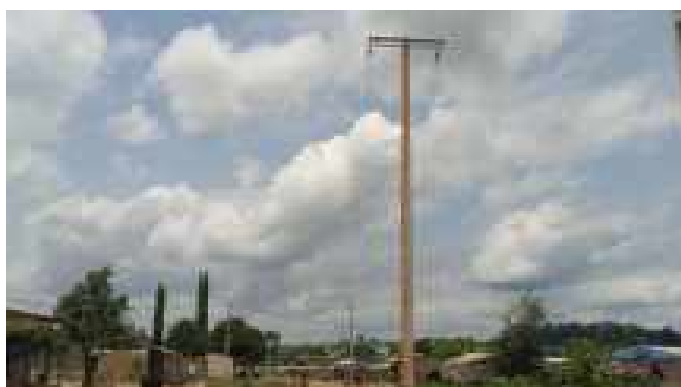
Photo 4: Vue de la ligne existante
