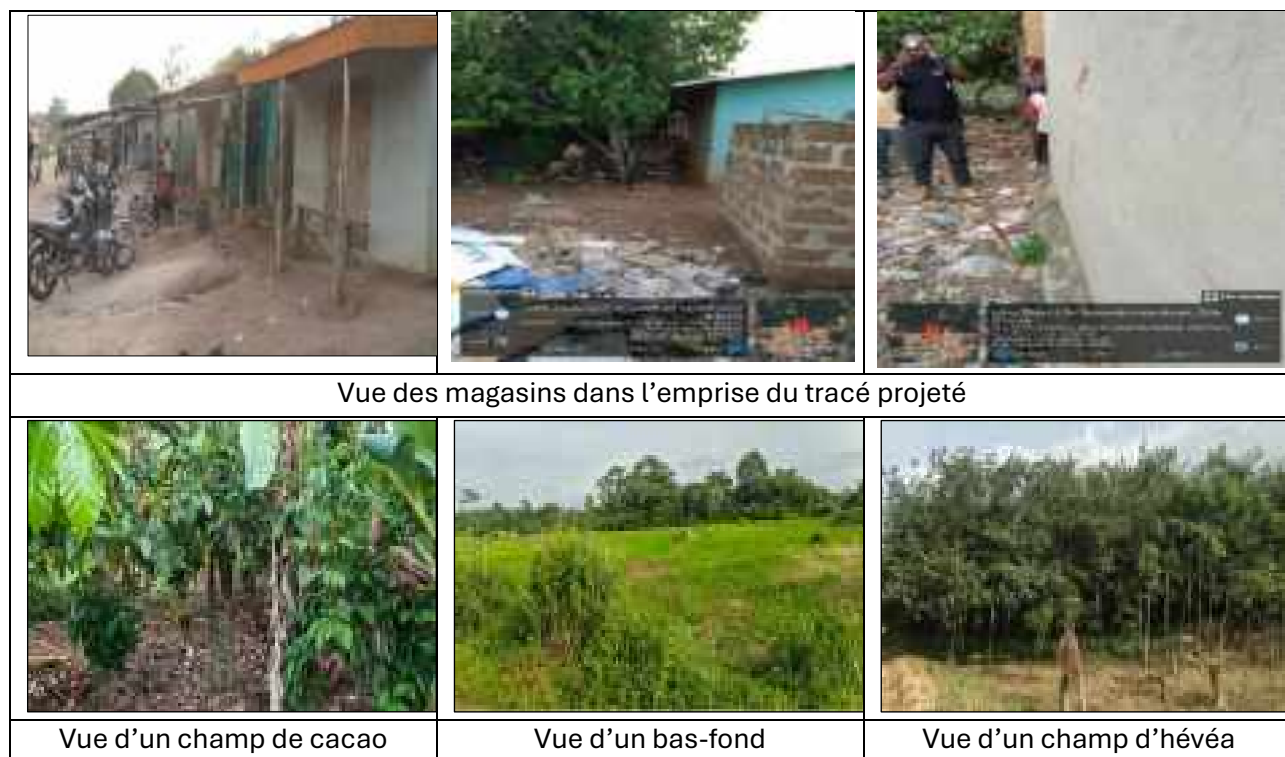
Planche 2 : Vue de l'occupation du sol dans l'emprise de la ligne HT
