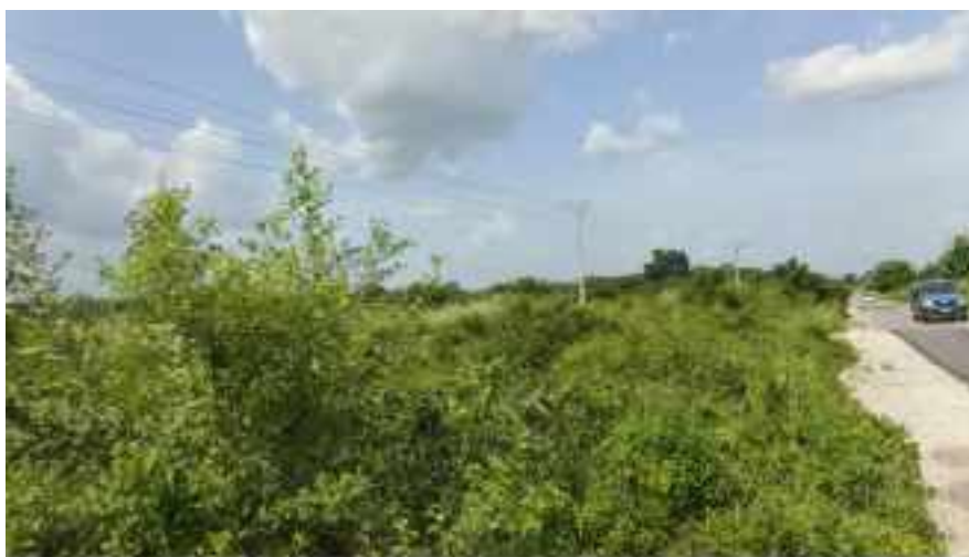
Photo 6 : Vue de la Ligne existante de Loukrou
