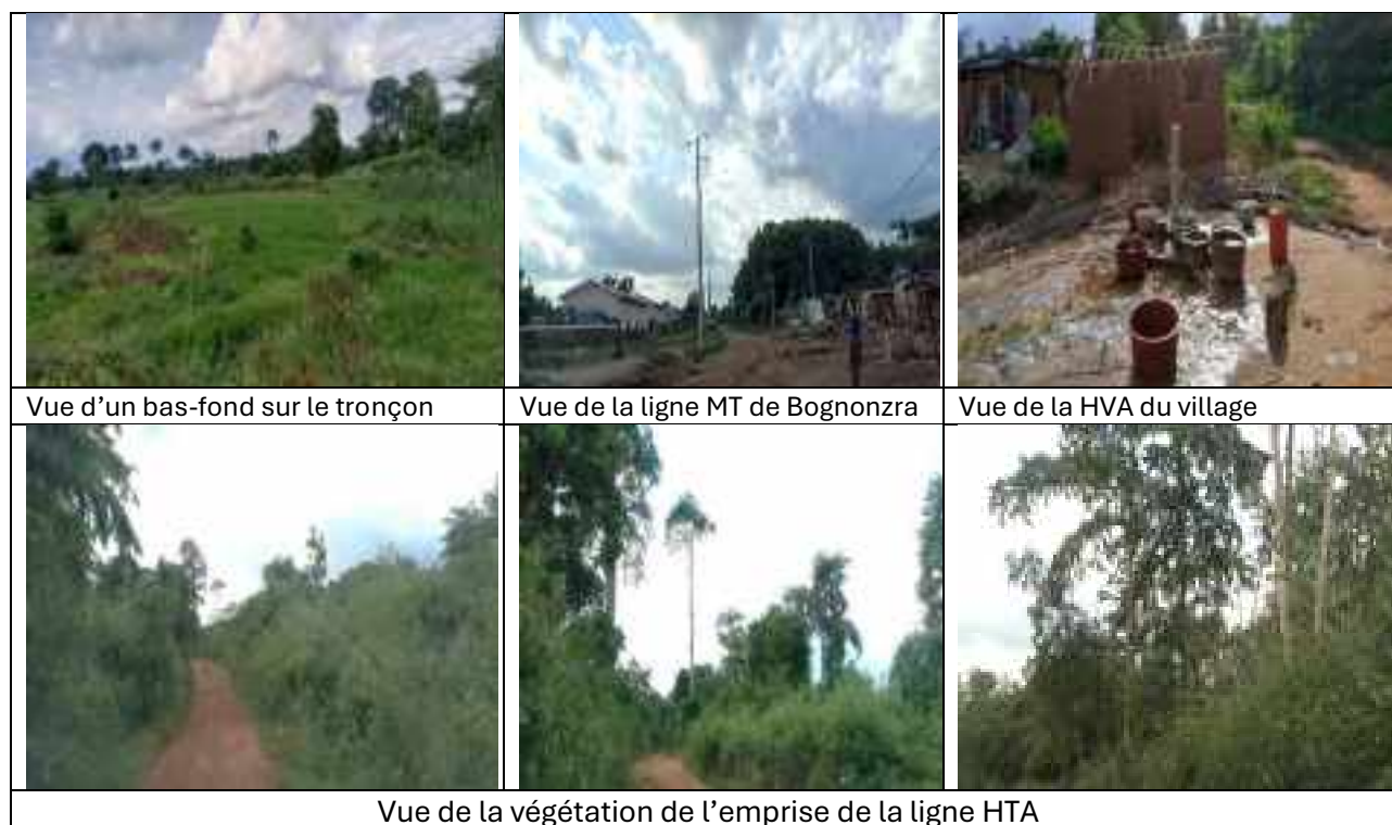
Planche 20 : Vue de l'occupation de l'emprise de la ligne
