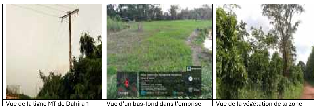
Planche 10 : Vue de l'emprise de la ligne projetée
