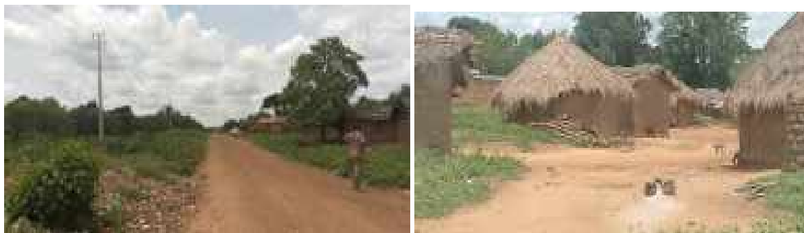
Planche 15 : Vue de la Ligne HTA de Kouamékaha
