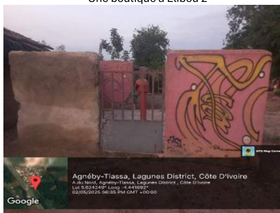
Une pompe à motricité humaine à Elibou 2
